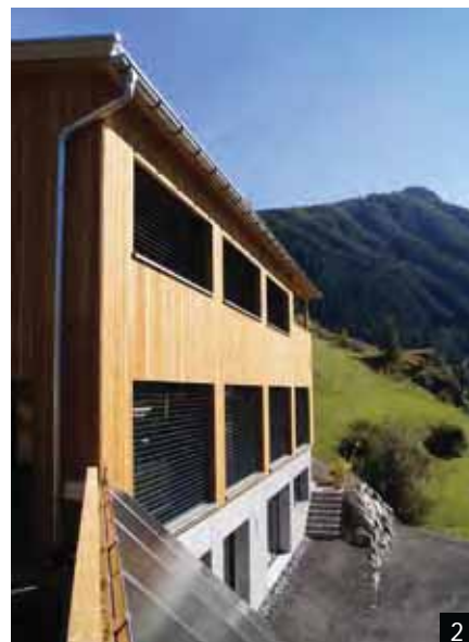
1: Das Sonnenlicht wird durch passive Nutzung, thermische Kollektoren und eine PV-Dachanlage optimal ausgenutzt.
