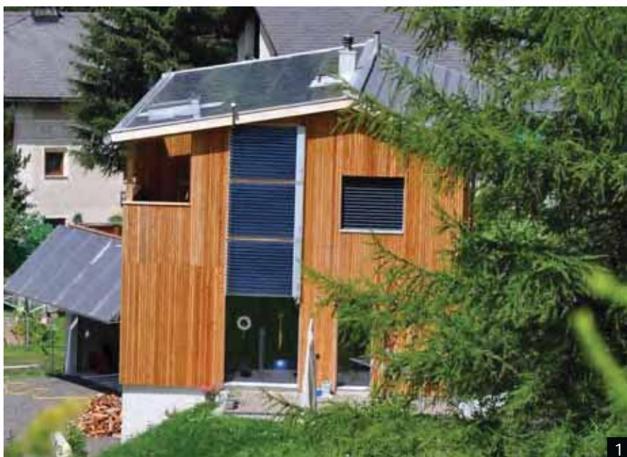
1: Das Sonnenlicht wird durch passive Nutzung, thermische Kollektoren und eine PV-Dachanlage optimal ausgenutzt.
