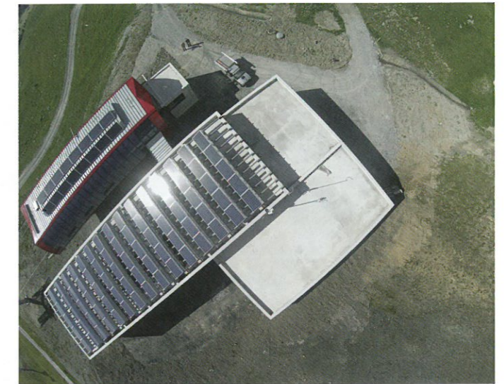
Sesselbahn-Photovoltaikanlage der LBB AG.
