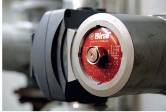
Wärmepumpen einer Heizungsanlage mit Energieoptimierung
